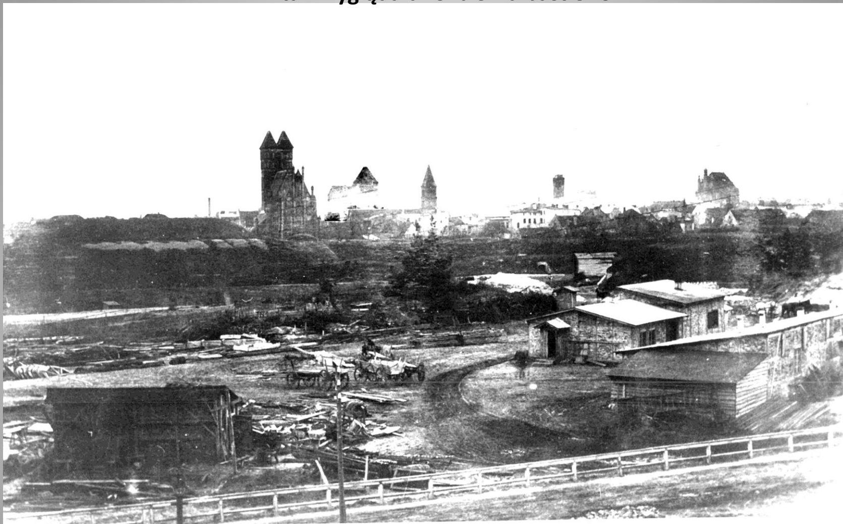
Rozbiórka bastionu II w 1884 roku
