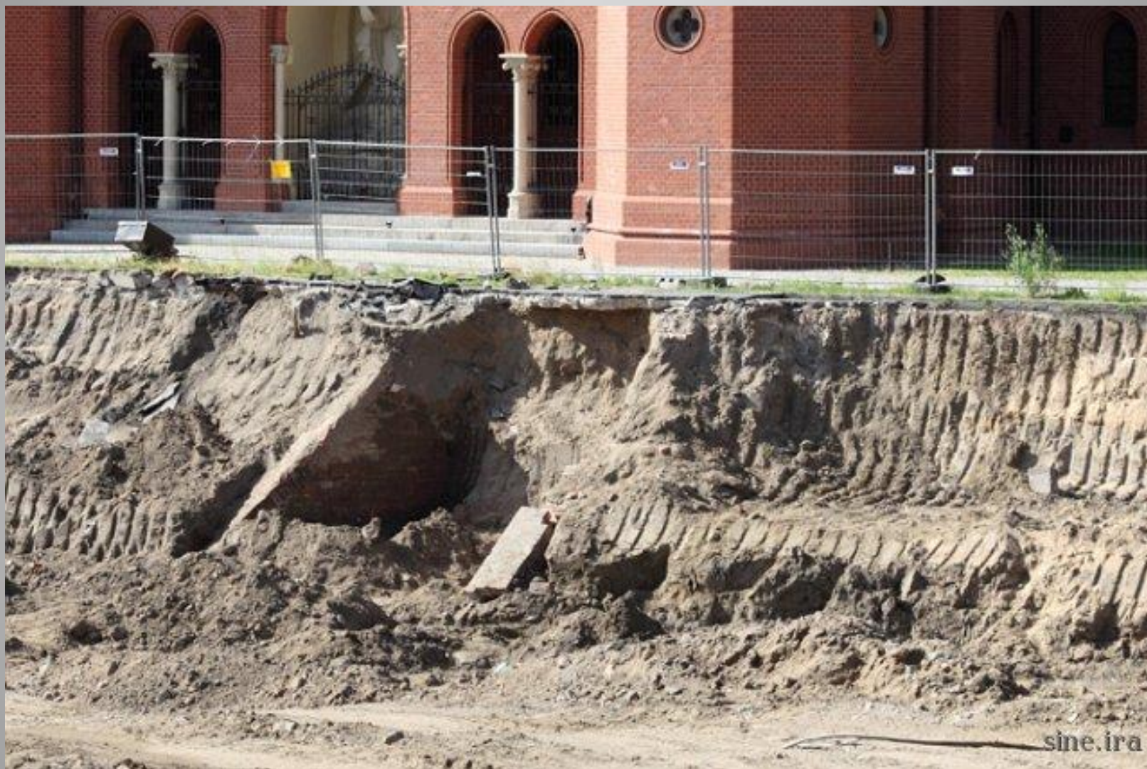
Murek oporowy kurtyny 2010 rok. Fot: sine.ira
